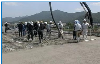
①コンクリート打設
