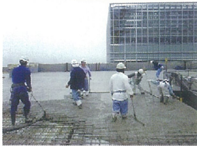
コンクリート打設・均し
